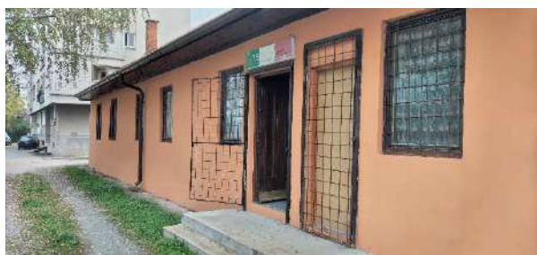
Zamjena krova i izgled eksterijera nakon radova
