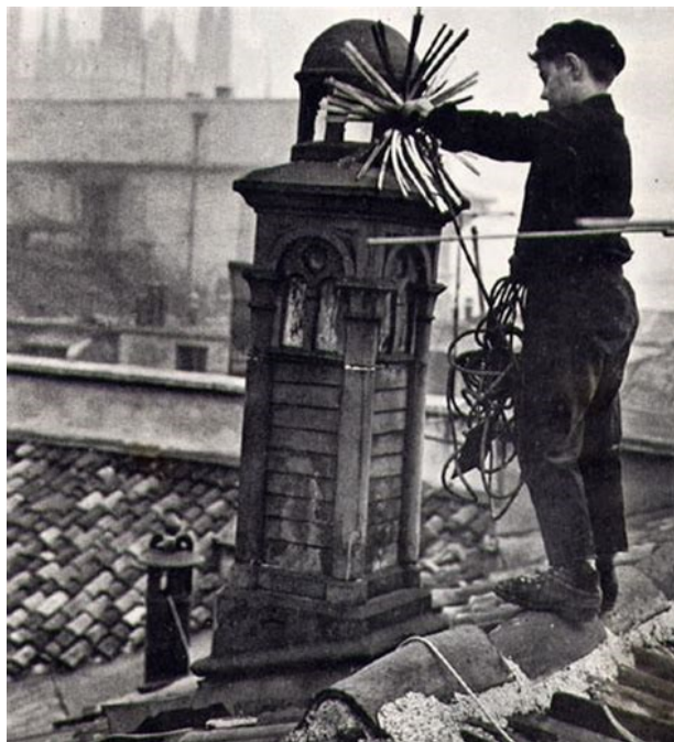
Dimnjačar, čišćenje dimnjaka
