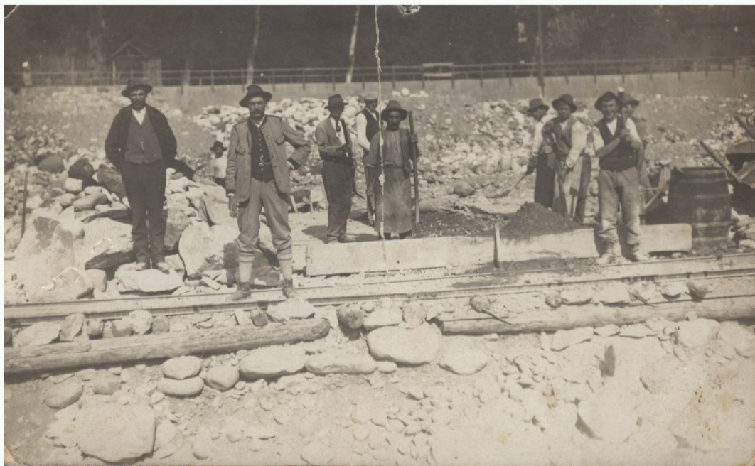
Obitelj Dorighi na radovima izgradnje pru- ge Šamac - Zenica
