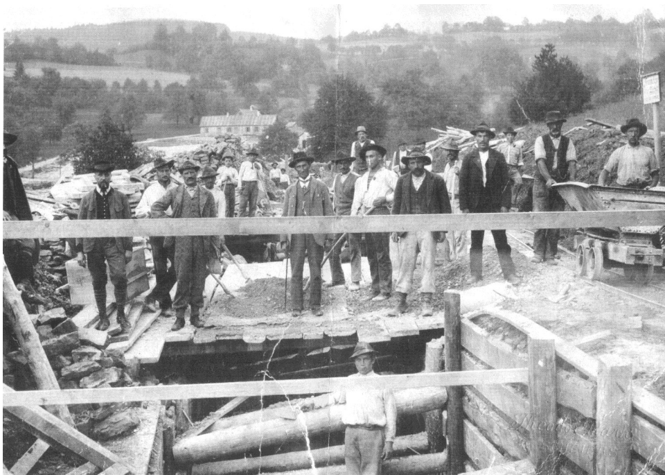
Obitelj Bancher na izgradnji tunela Vranduk
