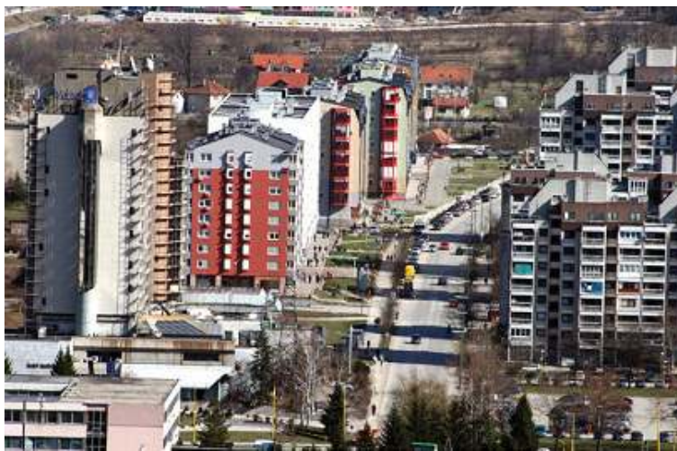
Novogradnja u Tuzli
