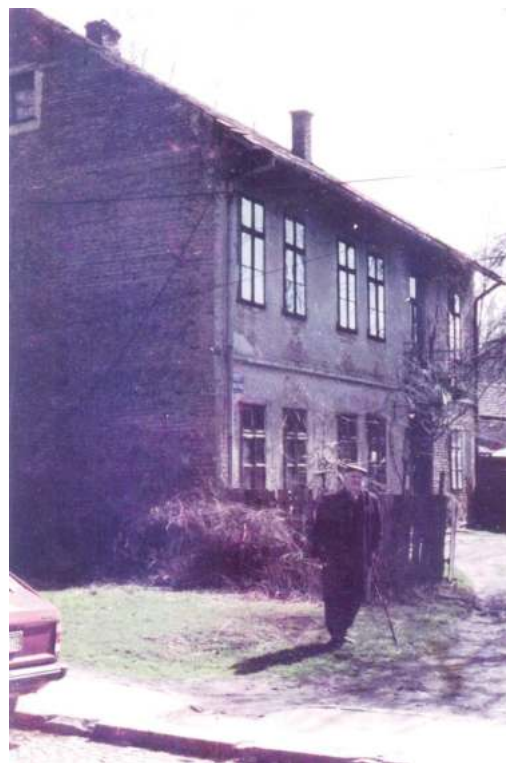
Posljednji sin Jakoba Motta, građevinski poslovođa Karlo - Dragutin ispred kuće prije rušenja
