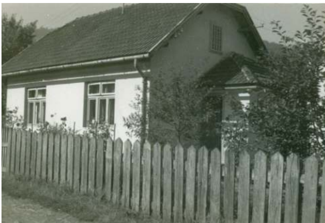
Kuća sa drvenom ogradom nakon dogradnje verande
