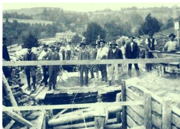
Bankerovi na izgradnji tunela Vranduk
