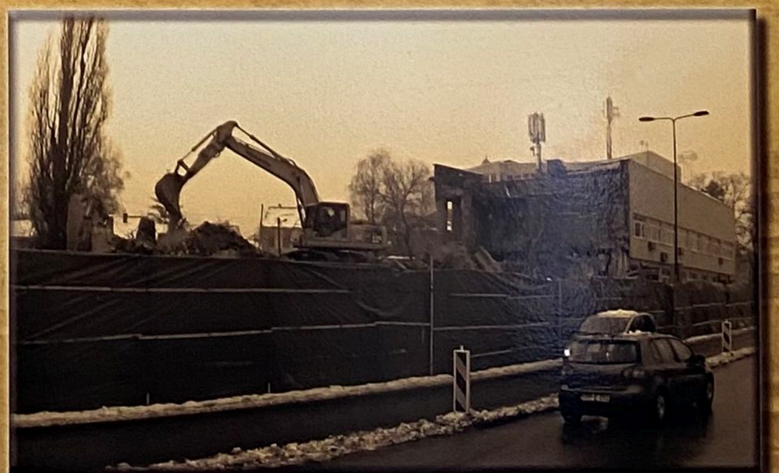
Fotografija rušenja zgrade Austrijske pošte/Narodne biblioteke, 22.11.2015. godine. (BiH - ATKI/FTG Z)
