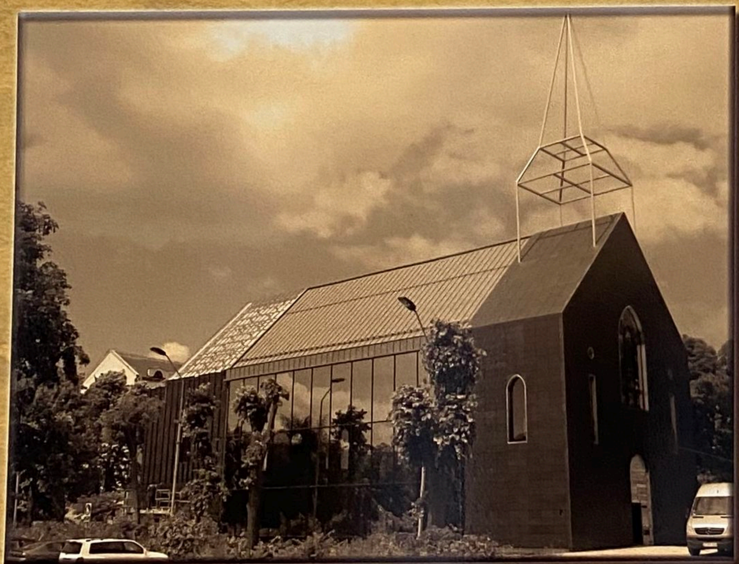
Izgled katoličke crkve koja se gradi na lokaciji porušene, stare crkve. Fotografija iz juna 2017. godine. (BiH - ATKI/FTG Z)
